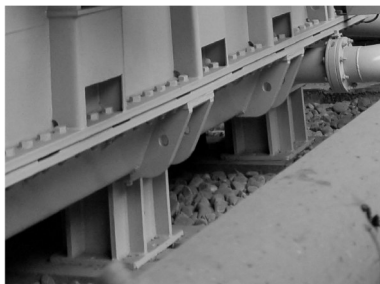
图5 变压器浮放安装
